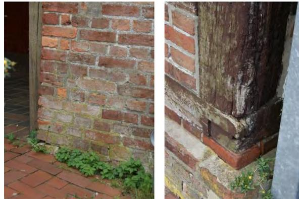
Abb. 62a/b: Schäden an Mauerwerk, Ständer und Schwelle
